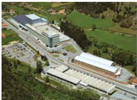
● Производственный комплекс в Риполе (Испания)
