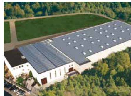
● Завод в Силс (Испания)
